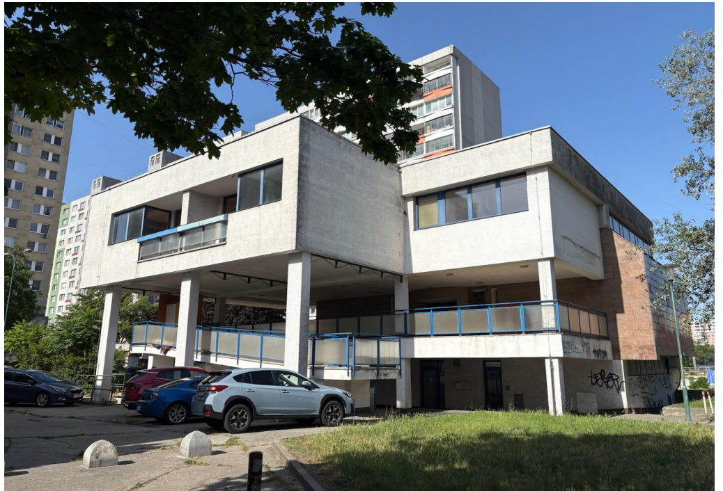
Pobočka VÚB na Rovniankovej čaká rekonštrukcia. Činnosť ukončila pred ôsmimi rokmi, odvtedy chátra. Foto: Martina Štefániková
