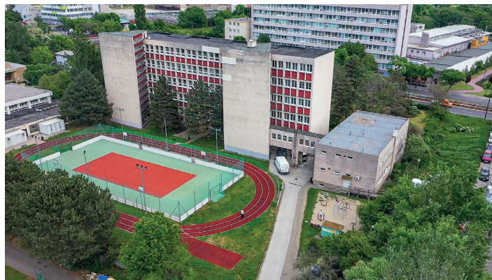
Obchodná akadémia, Račianska 107 pred rekonštrukciou
