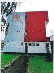
Vchod do bytovej časti.
