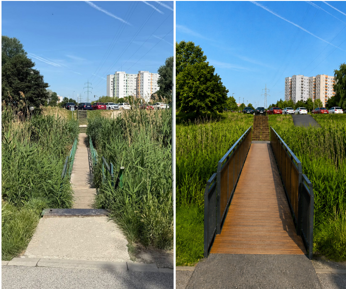
Lávka cez Chorvátske rameno pri Topoľčianskej – vľavo súčasný stav, vpravo budúca podoba. Jedna lávka by mala vyjsť samosprávu 100- až 140-tisíc eur bez DPH. | Foto a vizualizácia: MiÚ Petržalka
