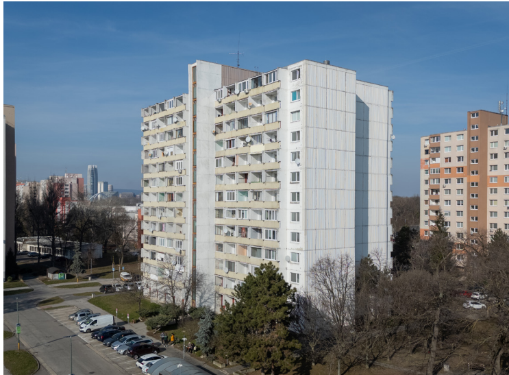
Bytový dom na Medvedovej čaká rozsiahla rekonštrukcia, náklady vyčíslila mestská časť na vyše 1,75 milióna eur. | Foto: Tatiana Šeliga
