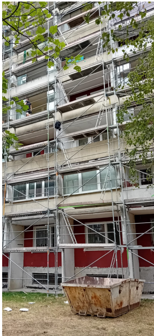
Stavebné práce začali v polovici augusta zateplením severozápadnej štítovej steny, následne sa pridala obnova lodžii. | Foto: MiÚ Petržalka
