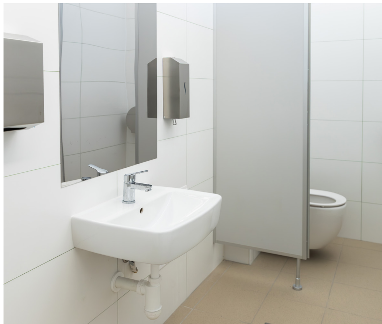
Najrozsiahlejšou rekonštrukciou prešli hygienické zariadenia na ZŠ Lachova.
