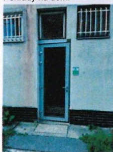
Vstup do bytovej časti.
